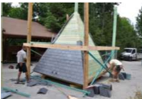
A természetes kőpalát a földön szögelik fel a toronyra.
